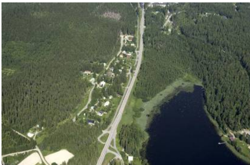
Kuva 2.3 Kairahta eteläpuolelta katsottuna ennen valtatielinjauksen puhkaisua asutuksen länsipuoliseen metsäiseen mäkeen
