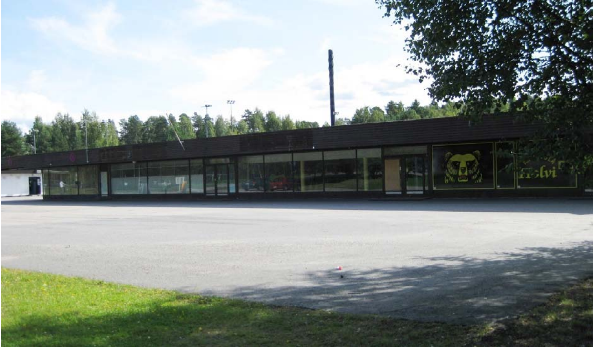
Jyväskylän Lohikosken ostoskeskus on rakennettu vuonna 1966. 1960-luvun ostoskeskukset ovat tyypillisesti yksikerroksisia tasakattoisia rakennuksia, joiden massoittelu korostaa mataluutta ja vaakasuuntaisuutta. Julkisivua jäsentää nauhaikkunat ja niiden väliset lasiovet. Kattorakenne on korostetun raskas.
