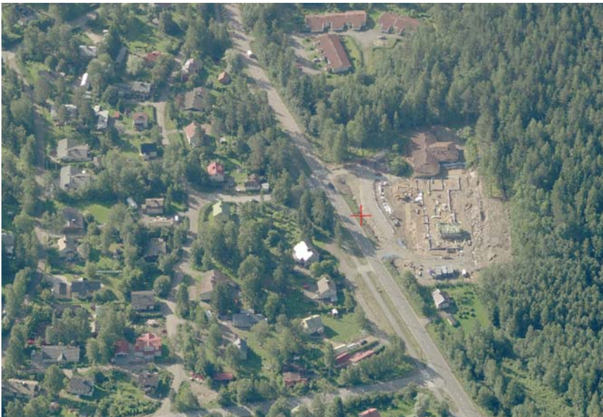
Kuva: Päiväkodin tontti rakennustyön alkuvaiheessa
