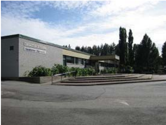
Huhtasuon koulun luoteisjulkisivu (Nina Äijälä 20.8.2009)
